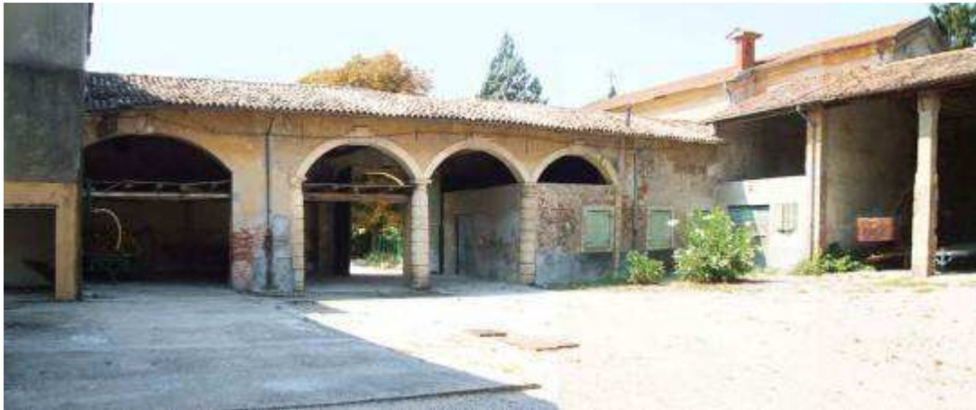
Figura 7.8.3.1/IV: porticato di accesso alla Bertacchina
