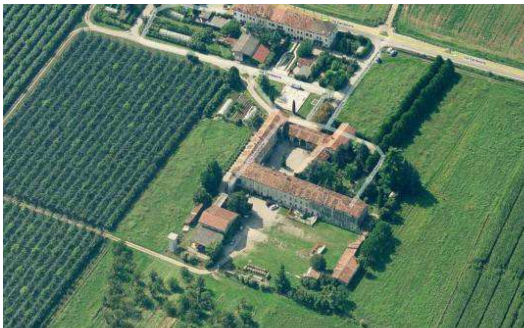
Figura 7.8.3.1/I: Vista panoramica della corte
